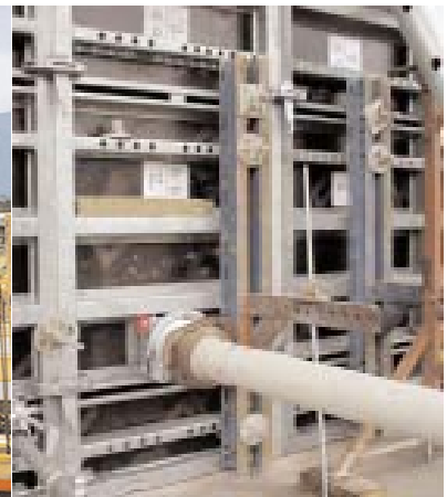
Pumpen in die Schalung
