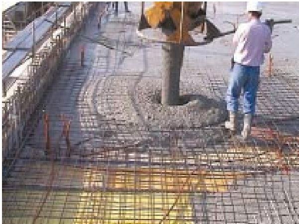
Betonieren mit SCC-Beton
