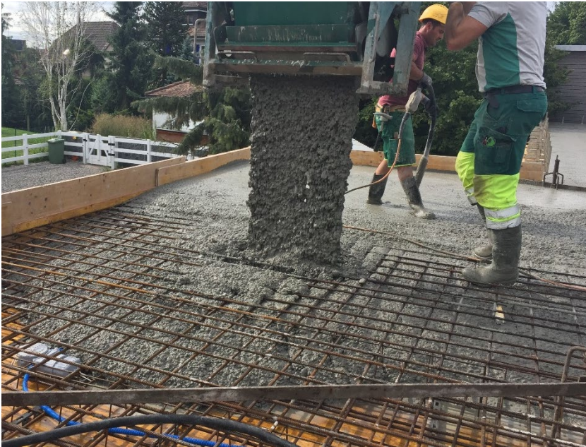
Betonieren mit LVB-Beton
