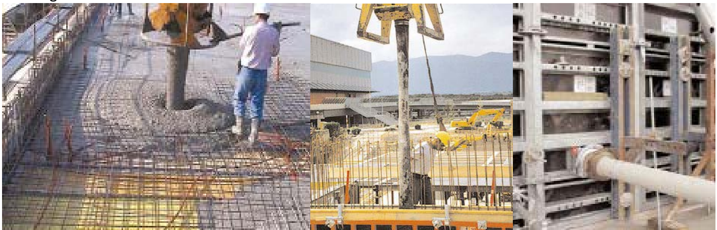
Betonieren mit SCC-Beton
