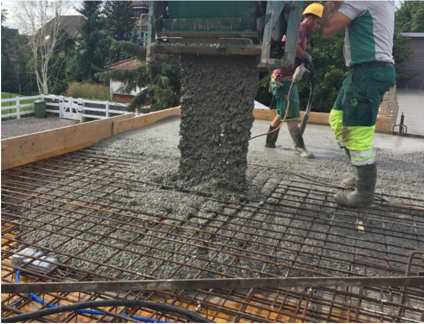
Betonieren mit LVB-Beton
